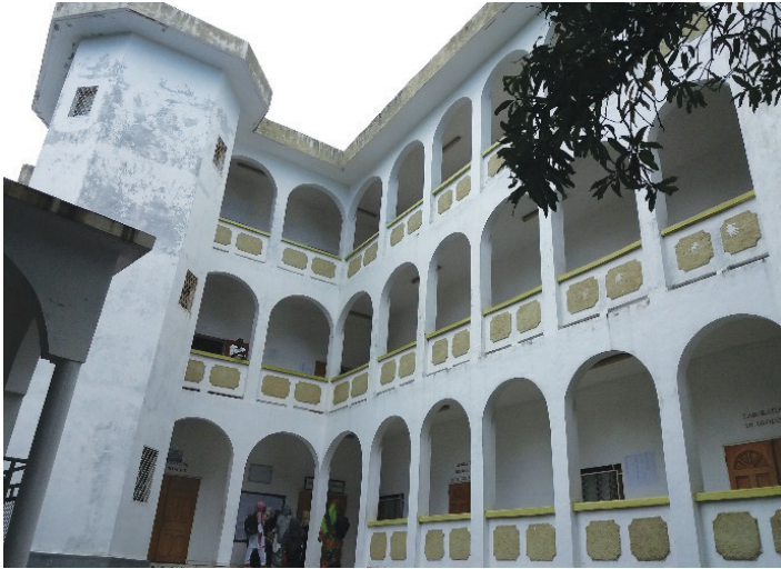
Façades ouest et nord protégées par des coursives couvertes
