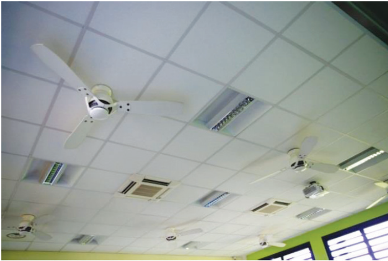
Calepinage d'une salle informatique climatisée et équipée de brasseurs d'air en évitant l'effet stroboscopique
