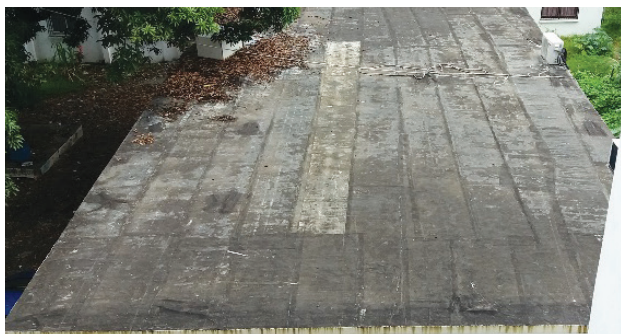
Toiture terrasse de couleur noire non isolée
