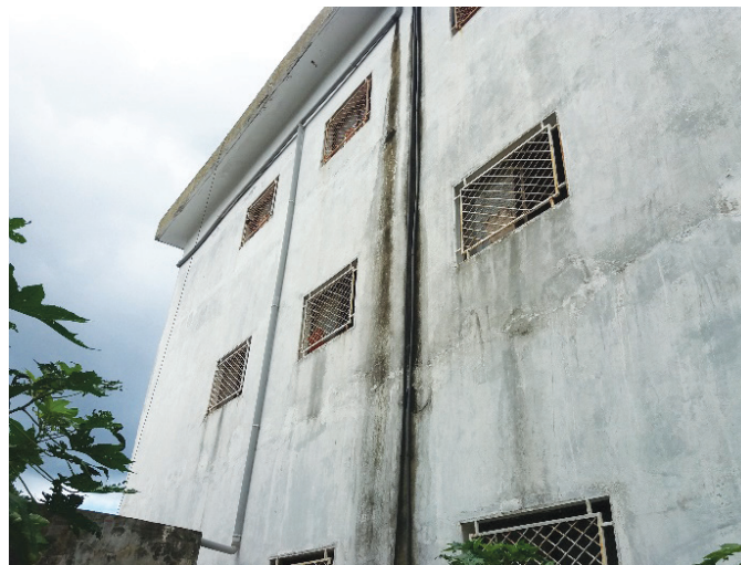
Façade est non protégée
