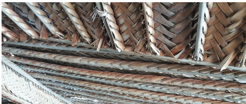
Mise en œuvre d'une sur-toiture ventilée – celle-ci peut être réalisée en paille de coco tressée
