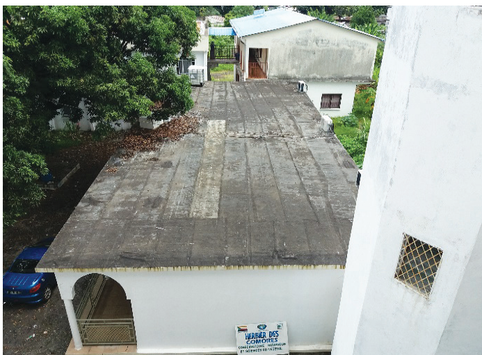
Toiture en béton de couleur sombre non isolée
